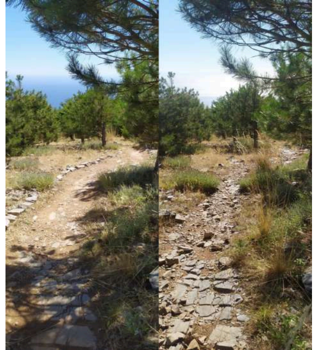
Πριν και μετά τις εργασίες συντήρησης στο μονοπάτι «Γκόλνα».
