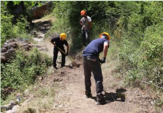
Μέλη της ομάδας της Ecogenia καθαρίζουν υπερβολική βλάστηση και συντηρούν βασικό τμήμα μονοπατιού για τη βελτίωση της προσβασιμότητας και τη μείωση του κινδύνου πυρκαγιάς.
